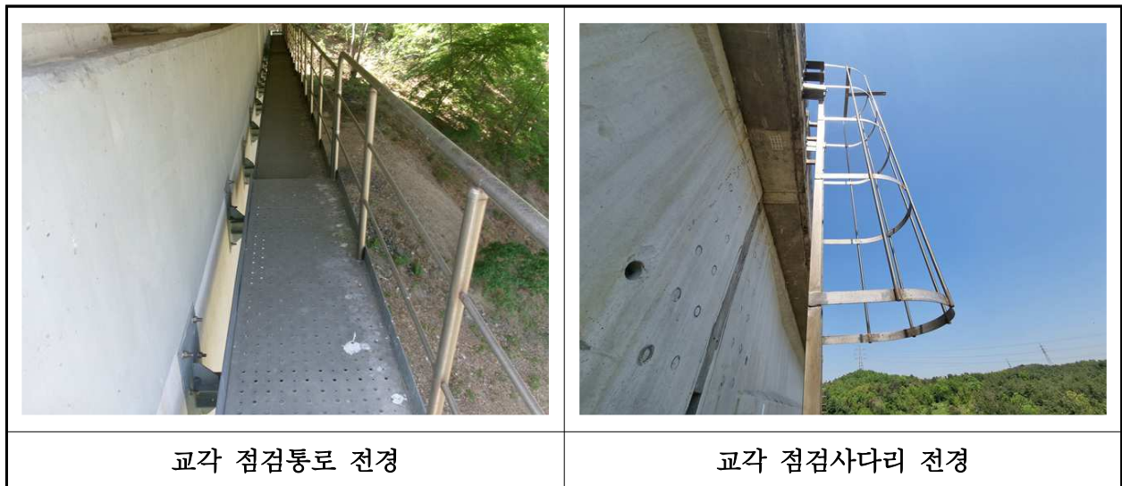
【사진 24.3.26】 교량 점검시설 전경
