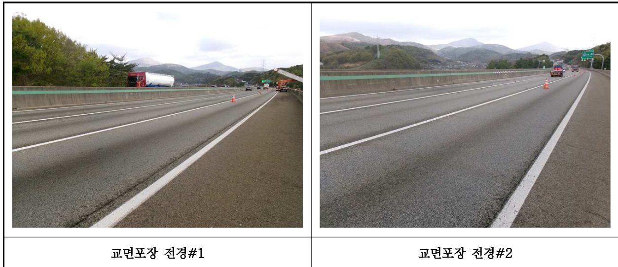
【사진 24.3.20】 교면포장 전경
