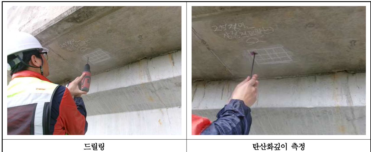
【사진 24.4.3】 탄산화 깊이 측정 현장사진
