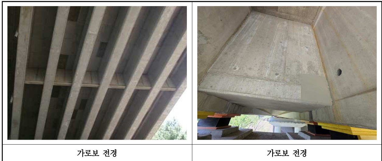
【사진 24.3.6】 가로보 전경
