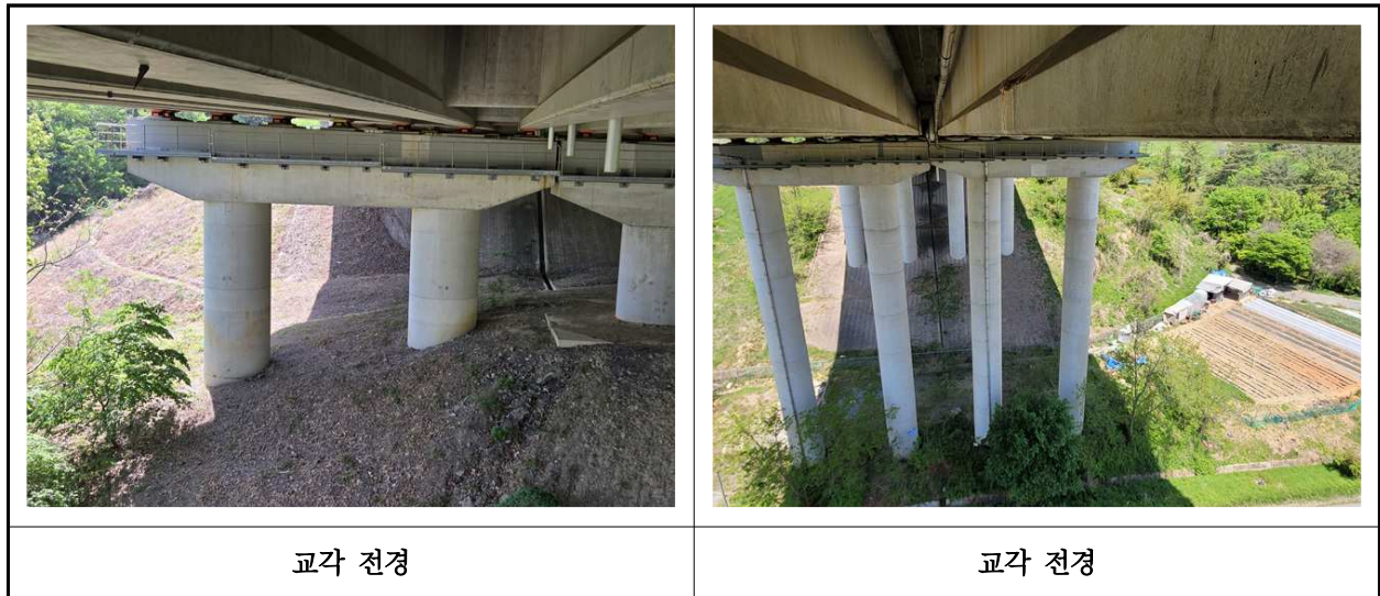
【사진 24.3.10】 교각 전경
