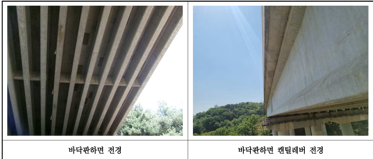
【사진 24.3.2】 바닥판하면 전경
