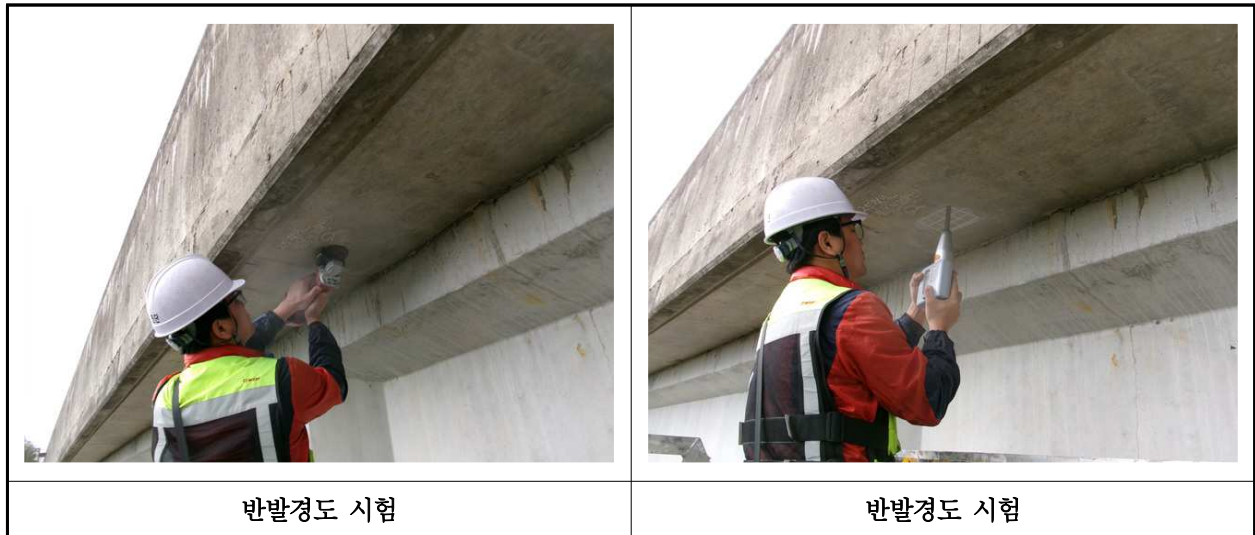
【사진 24.4.2】 반발경도시험 현장사진
