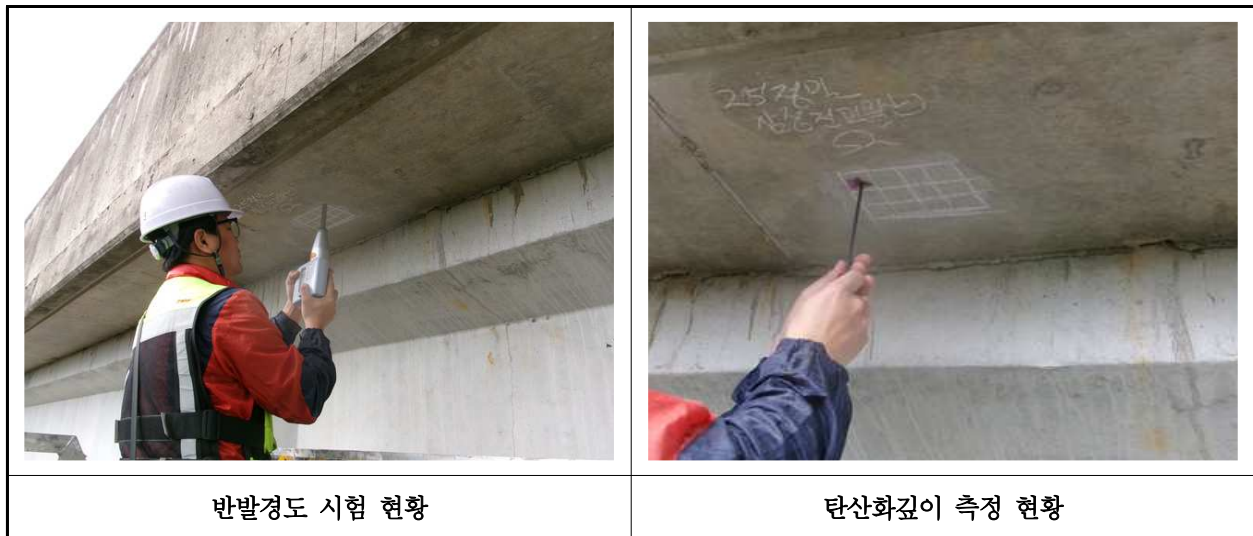
【사진 24.4.1】 콘크리트 내구성조사 현황
