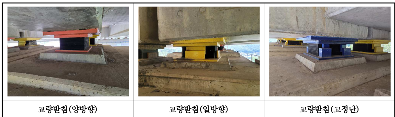
【사진 24.3.13】 교량받침 전경
