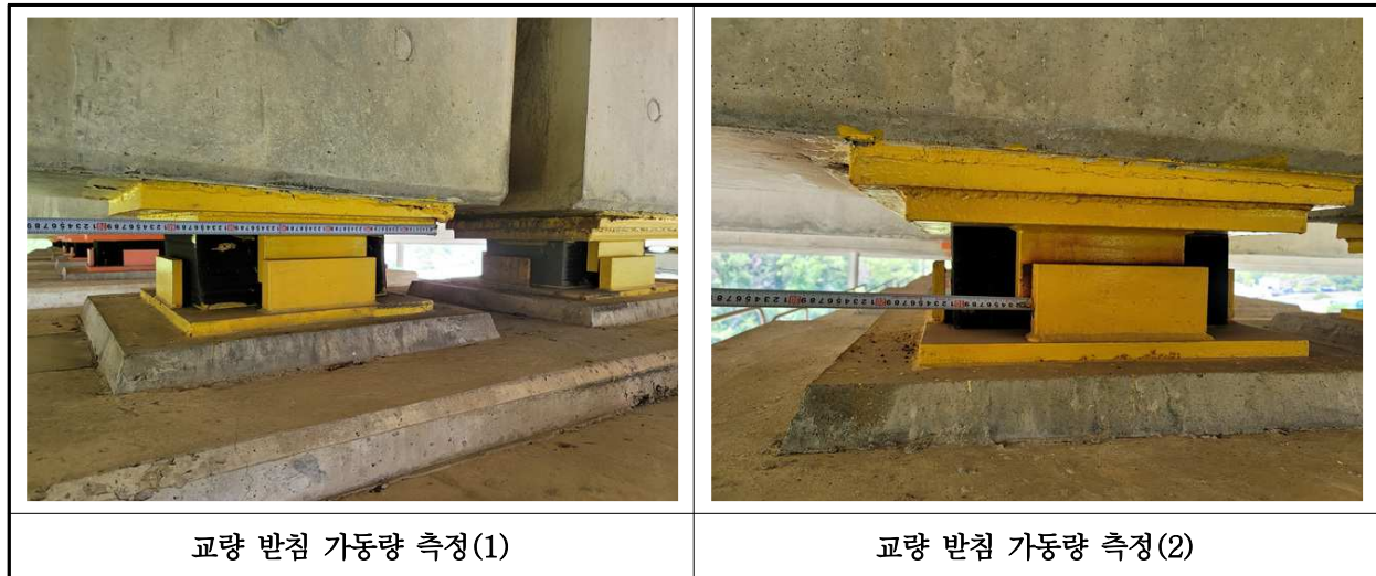
【사진 24.3.16】 교량받침 이동량 측정
