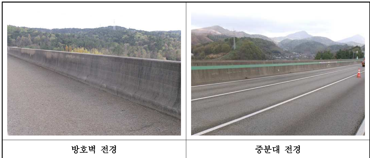
【사진 24.3.24】 방호벽 및 중분대 전경
