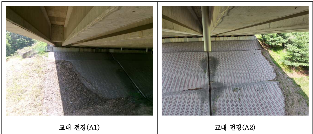
【사진 24.3.8】 교대 전경
